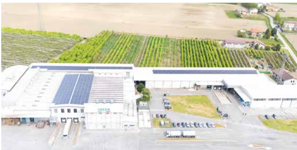
LA SEDE PRODUTTIVA DI GHEDA PETFOOD A OSTIGLIA (MN). L'AZIENDA, NATA NEL 1950, APPARTIENE DA 40 ANNI ALLA FAMIGLIA GHEDA E NEL TEMPO SI È TRASFORMATA DA PRODUTTORE DI PASTA PER CANI A UNA DELLE REALTÀ DI RIFERIMENTO NEL PANORAMA NAZIONALE PER QUANTO RIGUARDA IL SEGMENTO DEGLI ALIMENTI SECCHI, BISCOTTI E PRODOTTI PASTIFICATI PER PET
